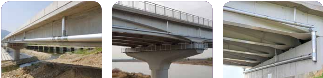
고덕국제화 계획지구 도로건설공사 중 교량배수시설 설치공사
