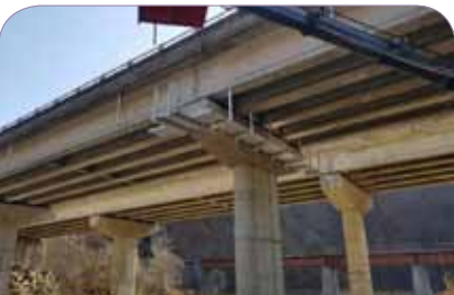
STEP 3: 통로발판 설치
