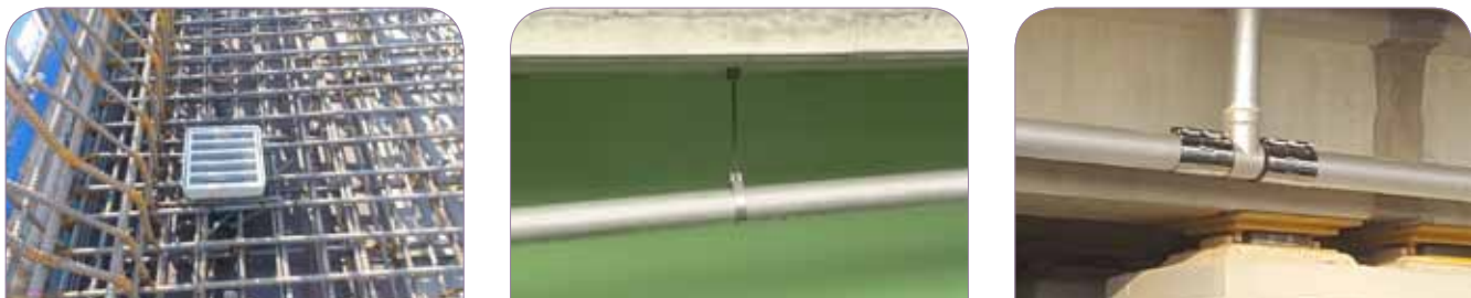
STEP 1: 현장실측 후 집수구 설치
