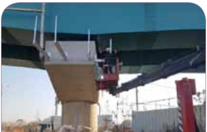
STEP 2: 고정부(메인포스트) 설치
