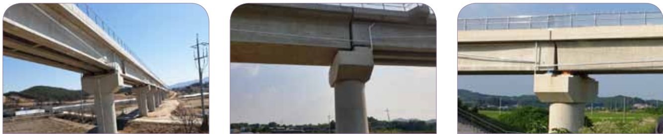
이천~충주 철도건설 2공구
